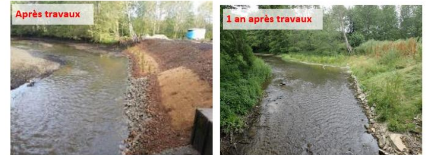
Exemple d'arasement d'un ouvrage et renaturation du lit (Cariçaie)
