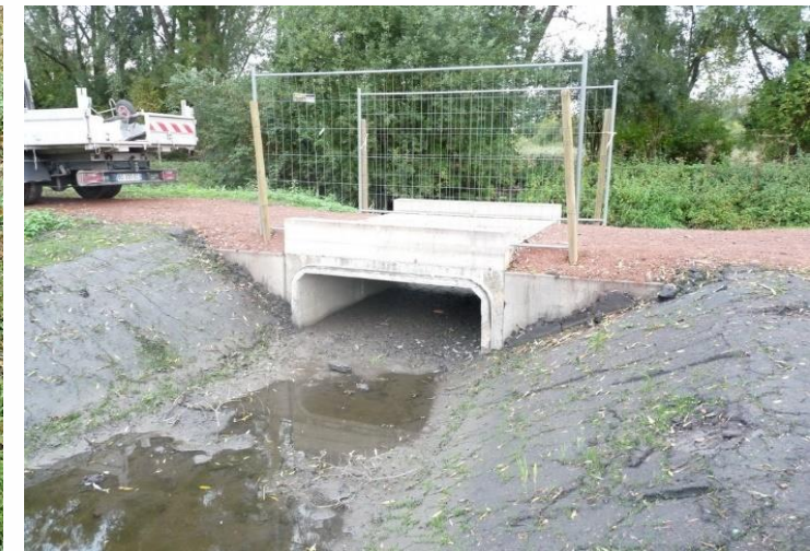
Construction d'un dalot
