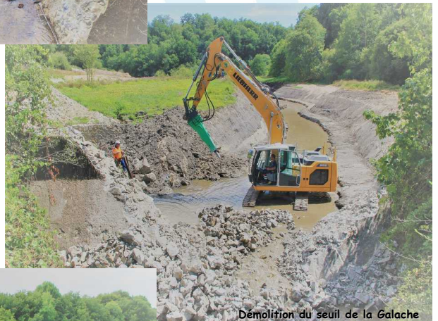
Démolition du seuil de la Galache
