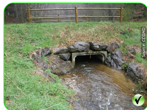
Buse cadre enterrée au 1/3
