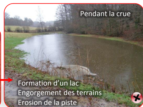
Buse sous-dimensionnée
