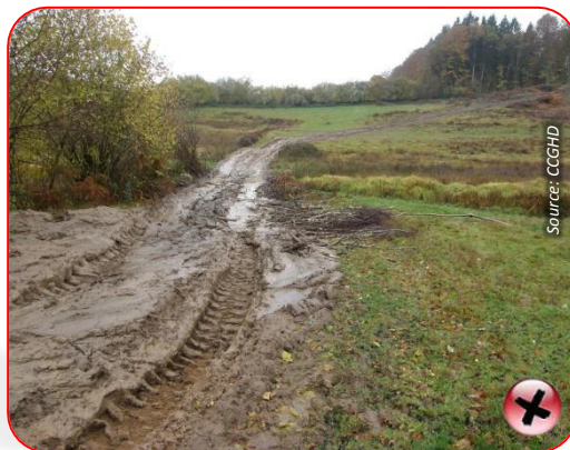
Erosion de piste
