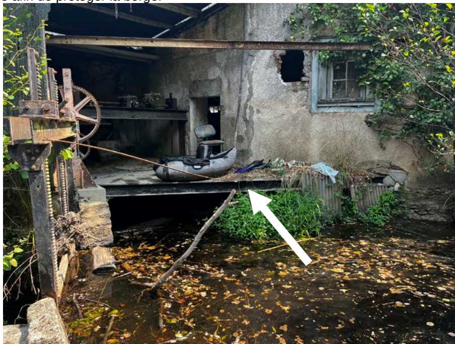
Prise d'eau du moulin à conserver
